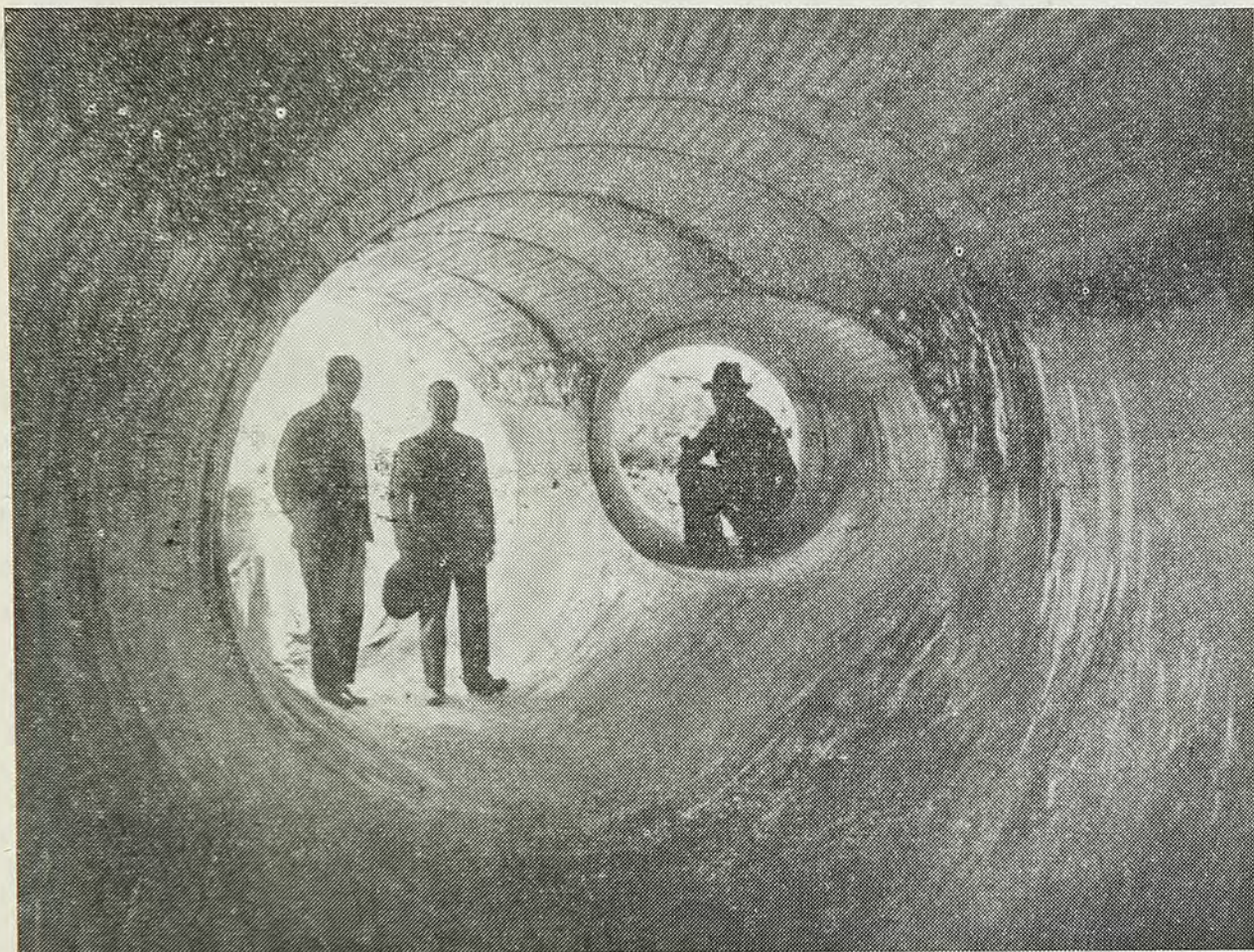
N.º 1.—Empalme de colectores. Sector Norte Santiago
